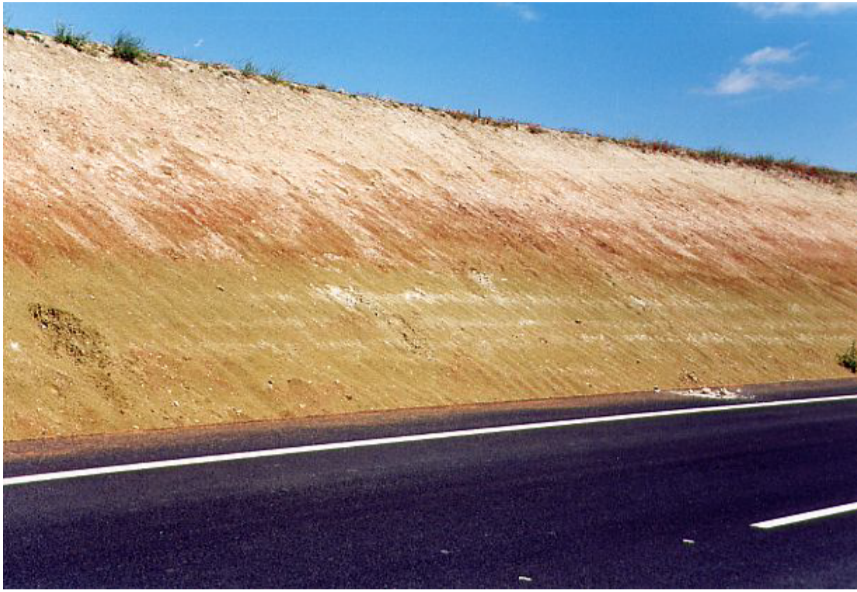
Fotografía 6.- Columna de Almodóvar del Campo I. Sucesión de arcillas verdes y rojas sobre las que se instala una capa de caliza.
