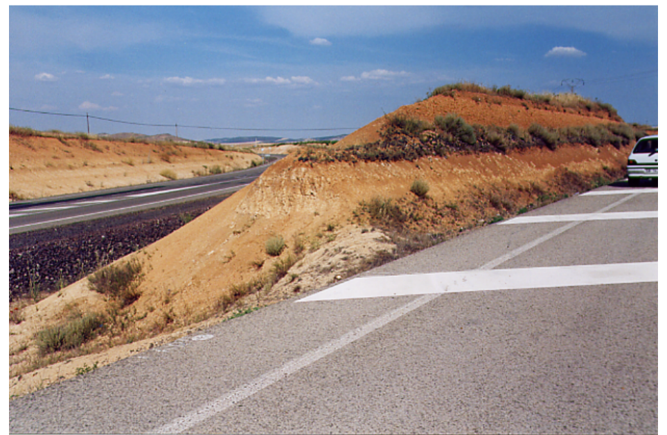
Fotografía 69.- Columna estratigráfica de Calzada de Calatrava I. Sedimentos finos de limos y arcillas. Hacia la parte superior se da un aumento de las rizocreciones.
